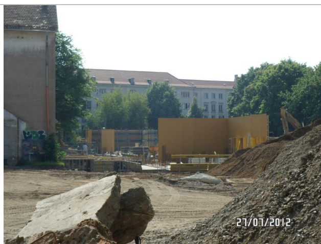
Foto 6: Ansicht von WEST TO1 Baufeld TO3
