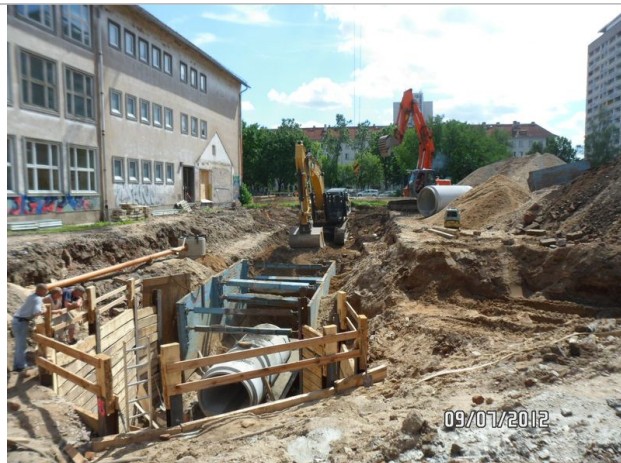
Foto 7: Ansicht LOS 8 Verlegung MW-Kanal
