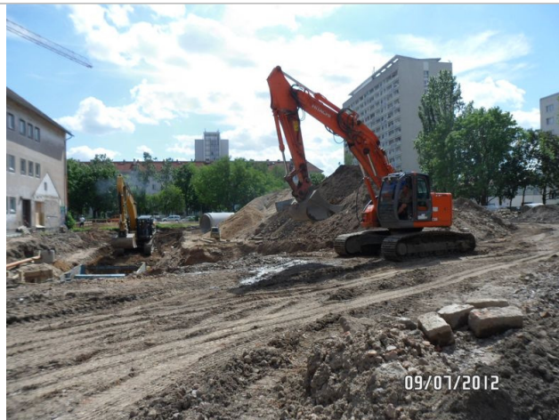
Foto 4: Ansicht LOS Verlegung MW Kanal
