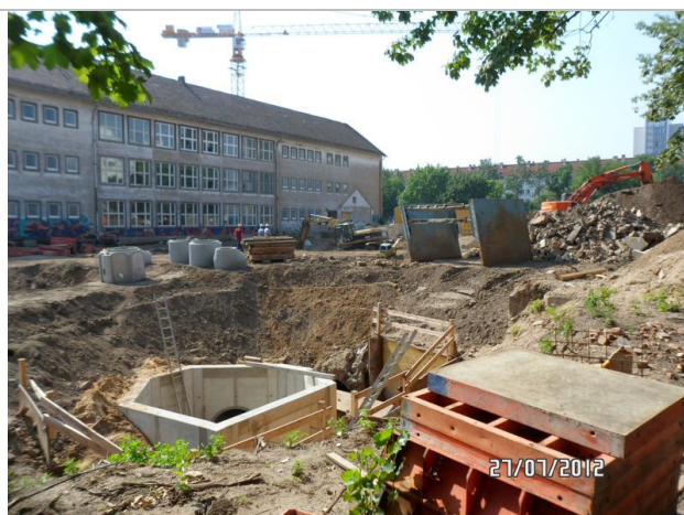
Foto 5: Ansicht LOS 8 Mischwassersammler
