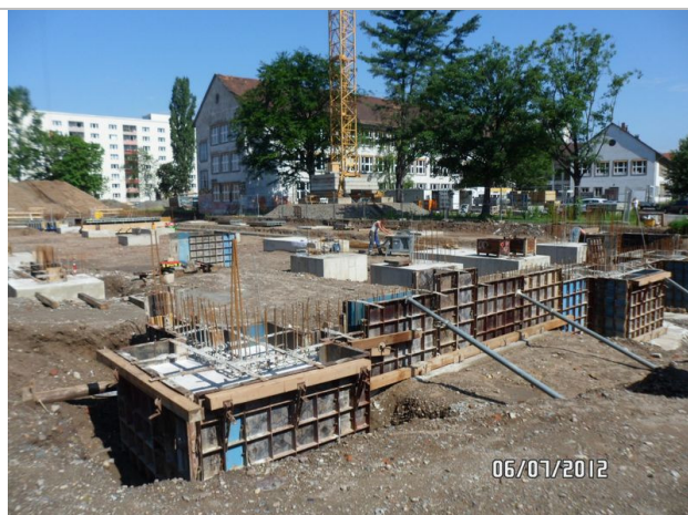
Foto 3: Ansicht TO1 LOS 10 Betonage Bohrpfaehlköpfe
