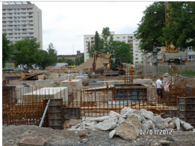
Foto 1: Ansicht TO1 LOS 10 Gründung Betonarbeiten
