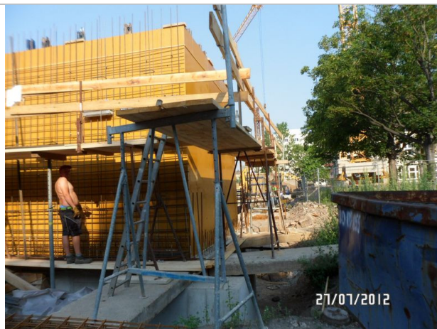
Foto 6: Ansicht LOS 10 TO1 Herstellen der Wände
