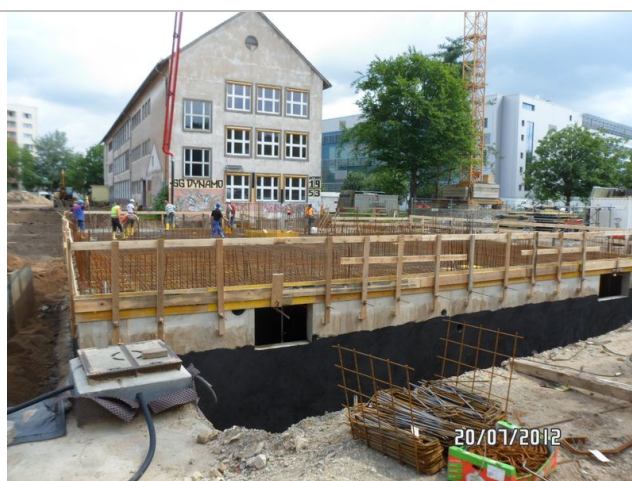
Foto 6: Ansicht LOS 10 KG Wände Abdichtung
