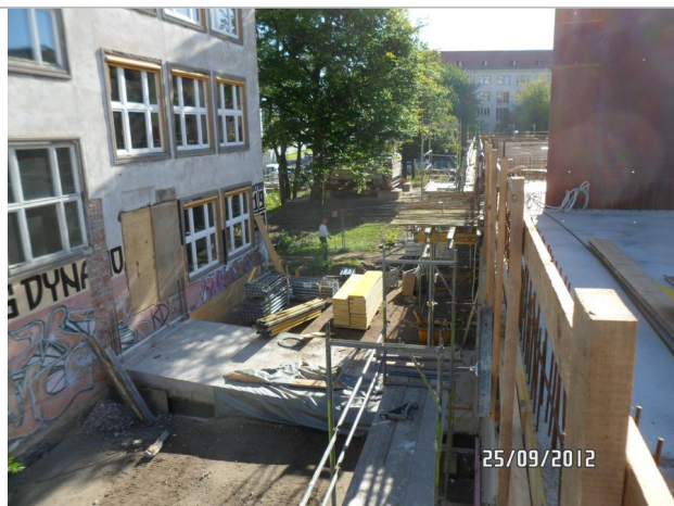
Foto 7: Ansicht LOS 10 Verbinder TO1 zu TO2
