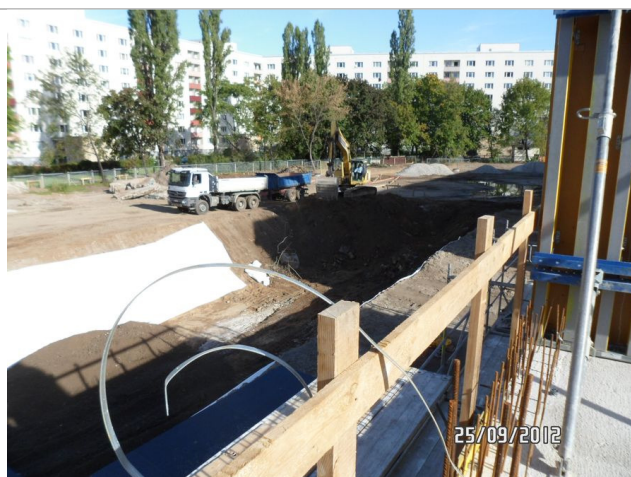
Foto 10: Ansicht LOS 10 TO3 Tiefbauarbeiten
