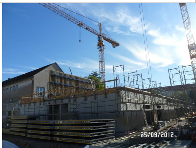
Foto 11: Ansicht LOS 10 TO1 Süd/West
