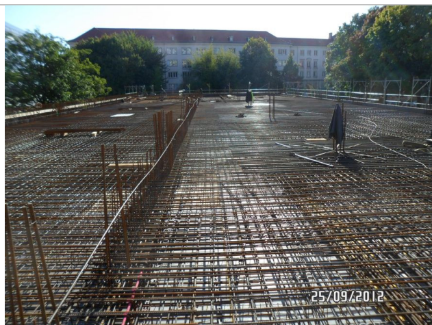
Foto 8: Ansicht LOS 10 TO1 Bewehrung EG Decke
