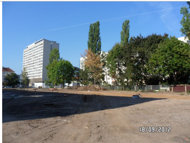
Foto 2: Ansicht LOS 8 Mischwasserkanal abgeschlossen
