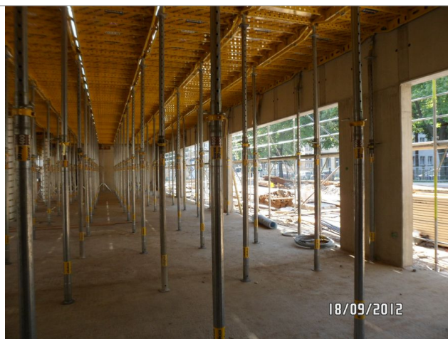
Foto 6: Ansicht West LOS 10 EG Speisesaal
