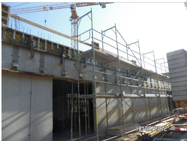
Foto 5: Ansicht LOS 10 TO1 von Süd/West
