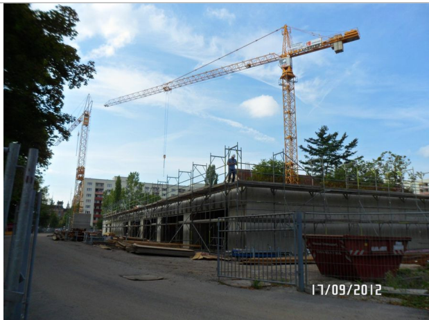
Foto 1: Ansicht TO1 LOS 10 EG Deckenschalung
