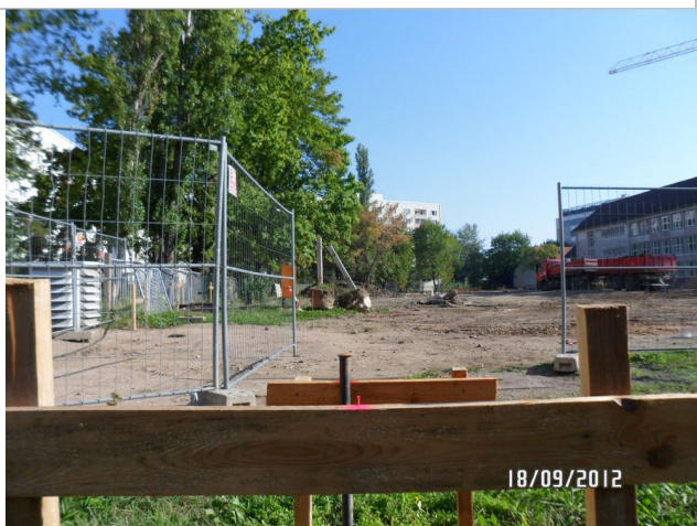
Foto 3: Ansicht Süd Los 10 TO3 Absteckung
