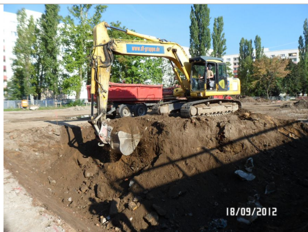
Foto 4: Ansicht LOS 10 TO3 Beginn der Tiefbauarbeiten
