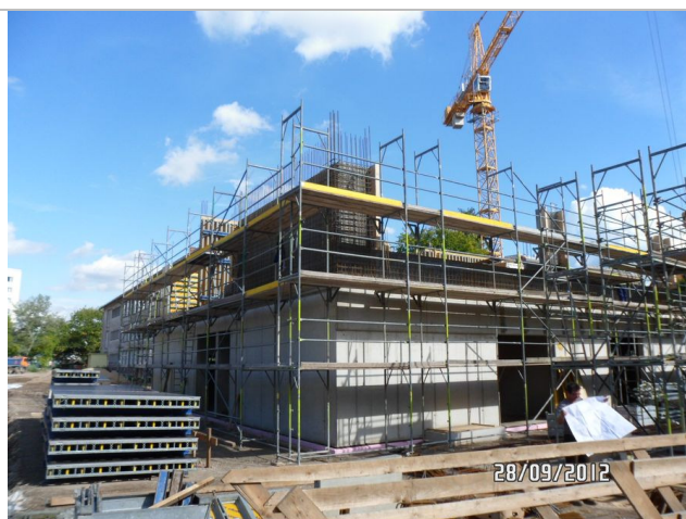
Foto 12: Ansicht Los 10 TO1 Süd/Ost
