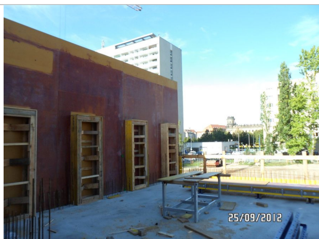
Foto 9: Ansicht LOS 10 TO1 Wände 1.OG
